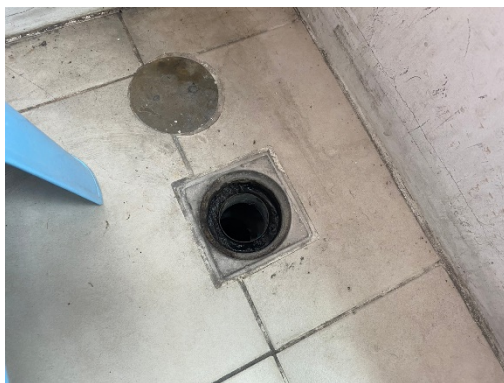
รูปที่ 22 ท่อรวบรวมน้ำเสียห้องพักขยะ
